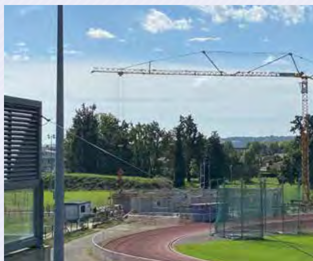
Le pôle associatif est en travaux et ouvrira ses portes en février 2022
