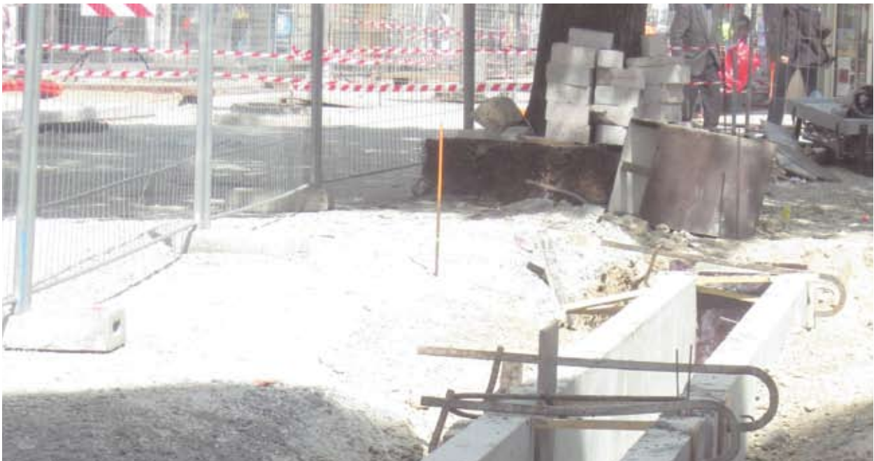
Pose du caniveau de la fontaine sèche à 6 jets
